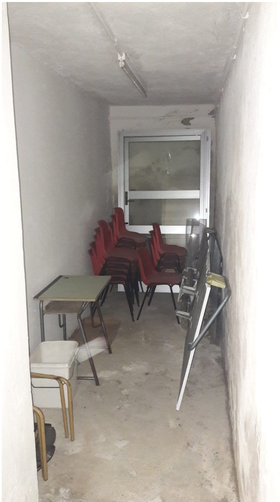
Vano chiuso da riqualificare per intonaco e umidità di risalita
